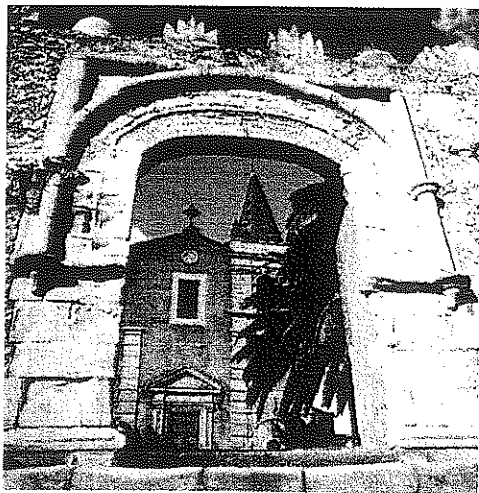
Forza d'Agrò, Chiesa della Triade, Complesso fortificato; Porta Ducezio, gotico-siciliano, particolare.
