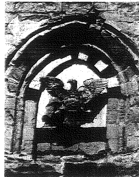
Troina, particolare architettonico della torre campanaria.
