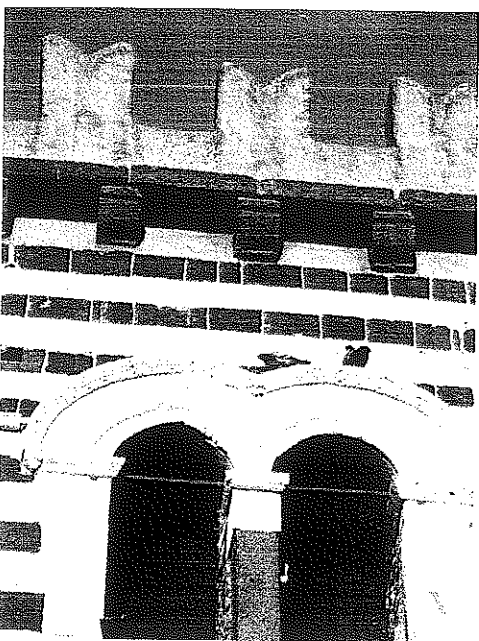
Santa Maria di Licodia, la torre medievale dell'Abbazia.
